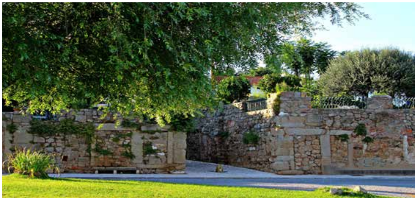
Muros dos antigos armazéns do Cais de Tancos cujos portais e as janelas nos recordam a azáfama de outras épocas e a importância deste porto – Foto de Maria Esteves
